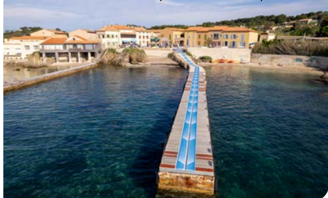
La conduite d'alimentation en eau potable de Giens à Porquerolles
